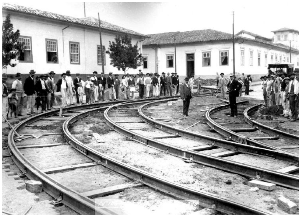
Figura 14. Instalação dos trilhos de bondes elétricos no Largo de São Francisco em 1900. Alguns anos mais tarde, as casas à esquerda, na esquina com a rua Senador Feijó, juntamente com outros imóveis, cederia lugar ao edifício da Escola de Comércio. Acervo da Fundação Energia e Saneamento de São Paulo.
