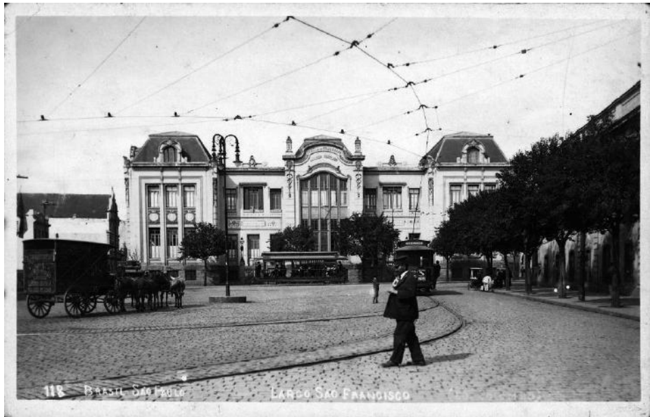
FIGURA 1: cartão postal mostrando o largo de São Francisco com destaque para o edifício da Escola de Comércio Álvares Penteado.
