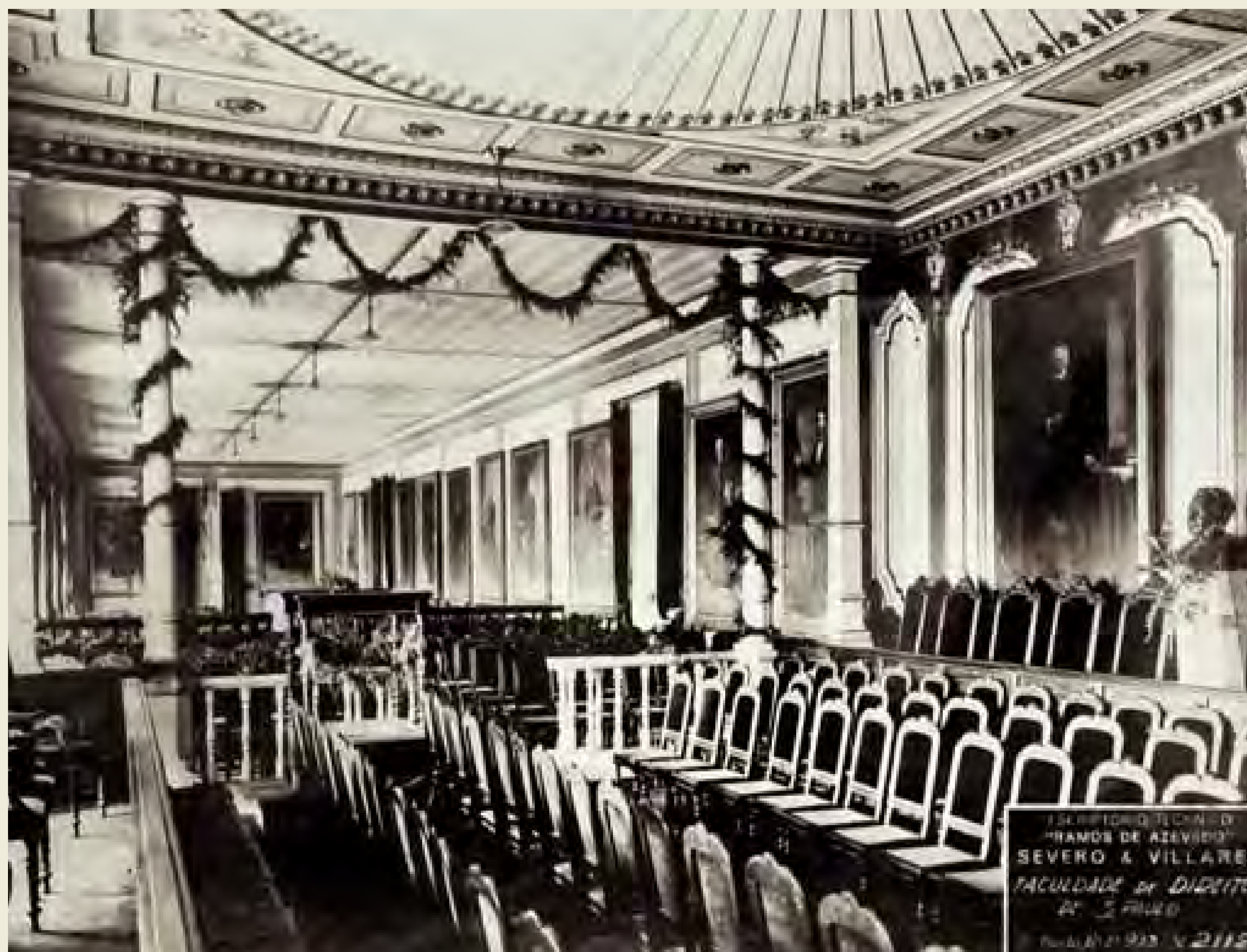
Vista do Salão Nobre da Academia, pouco antes de sua demolição em 1933.
