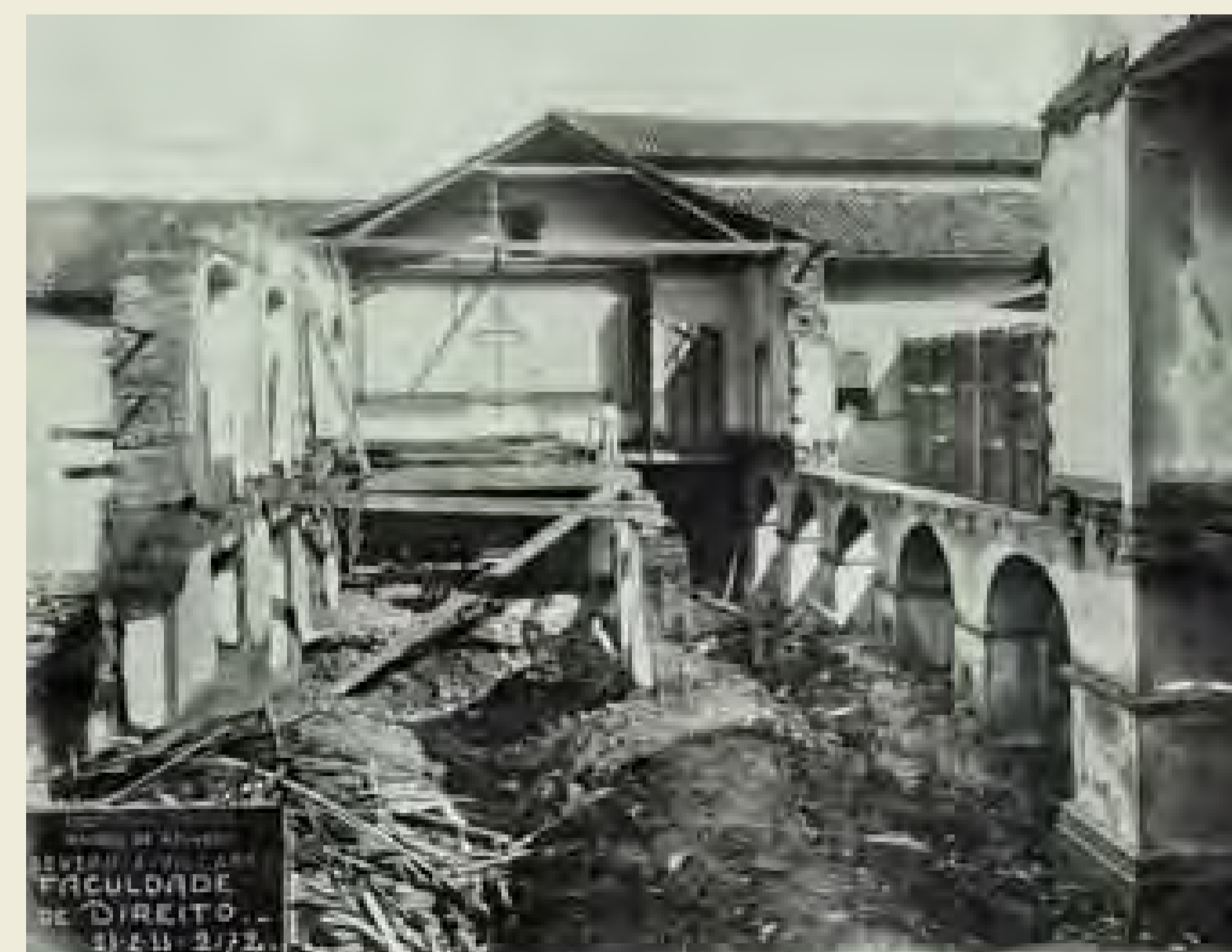
Aspecto da demolição do antigo prédio da Faculdade de Direito, em 1933.
